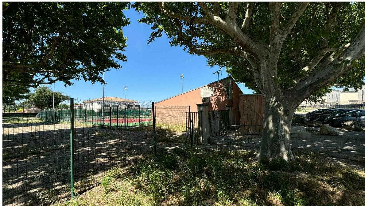
EXISTANT - PHOTOGRAPHIE PROCHE VUE 03
