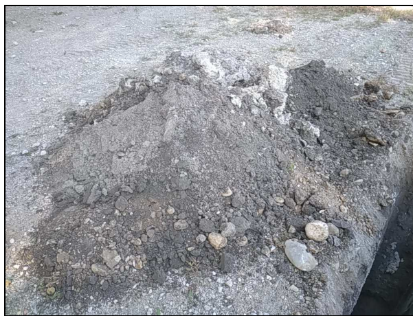
déblais de P1
