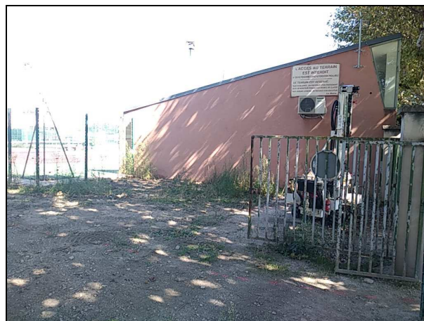
Vue vers le Nord-est
