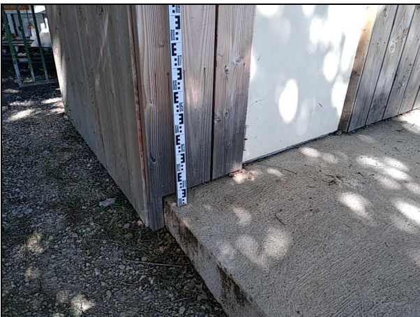
Vue du repère nivellement (dalle des toilettes publiques)
