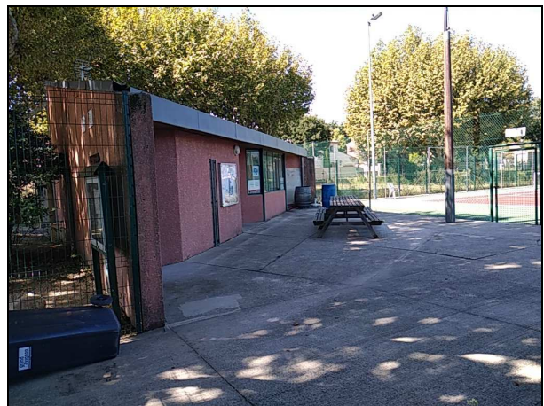
Vue du club-house M1
